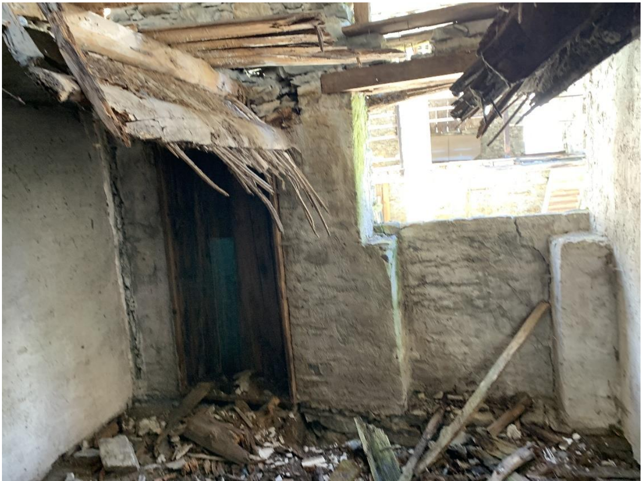
Scatto 14_State di fatto: interno piano primo solai in legno
