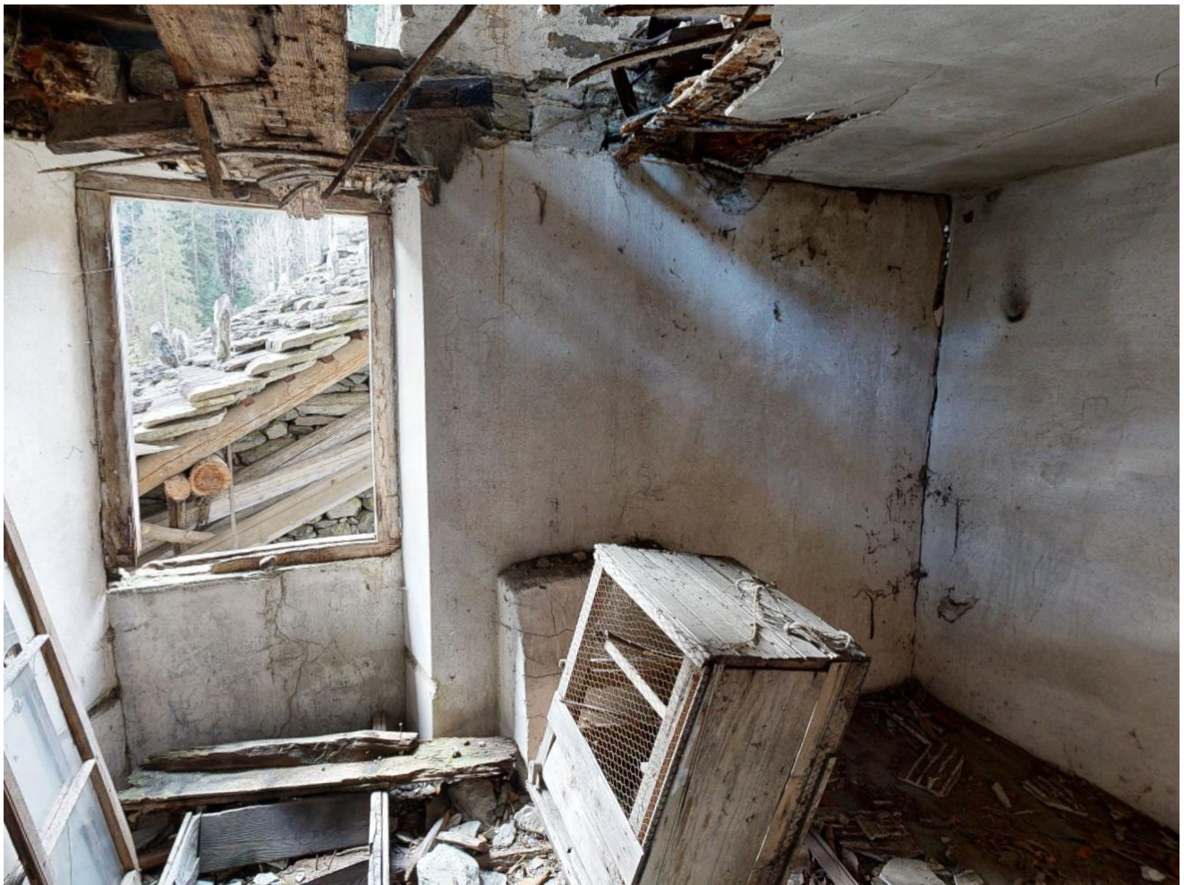
Scatto 15_ Stato di fatto: interno piano primo solai in legno
